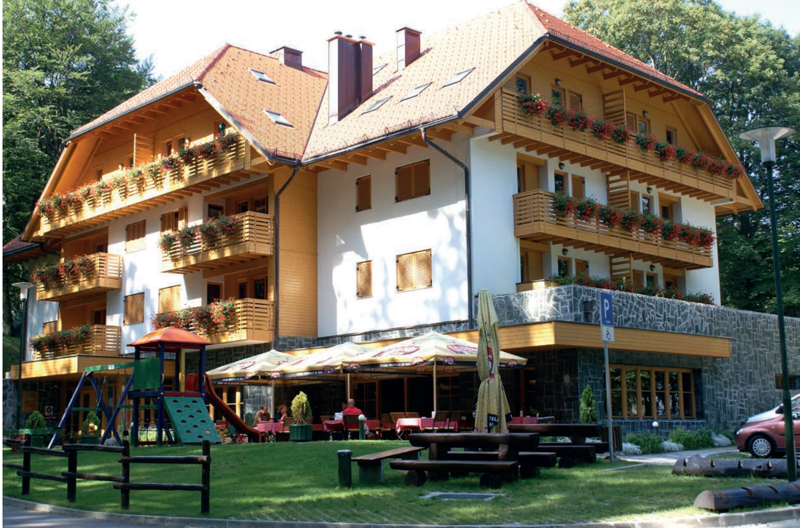
Apartmanska kuća Snježna kraljica
