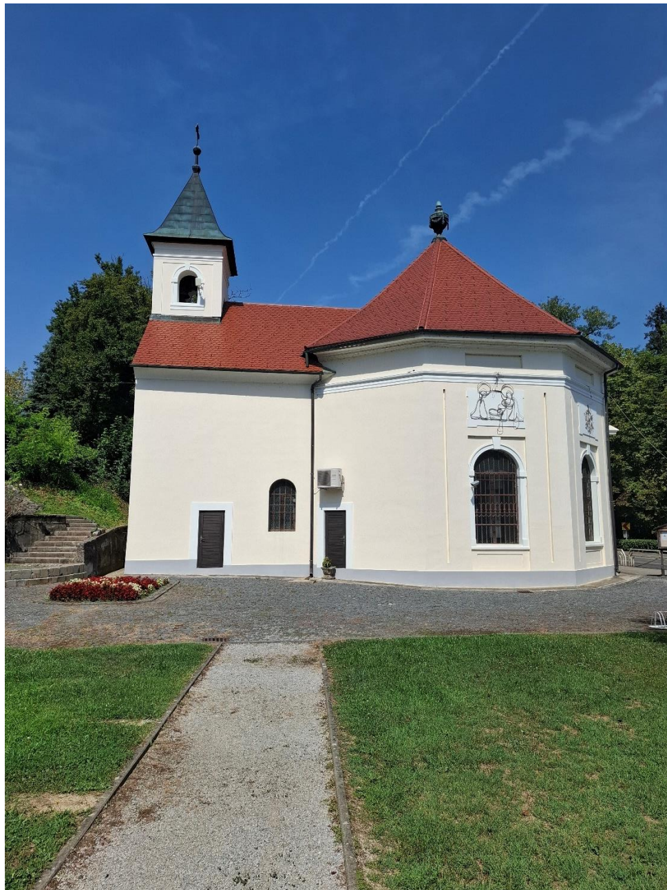
Slika 58. Kapela sv. Katarine u Stubičkim Toplicama, izvor: Level Project d.o.o.
