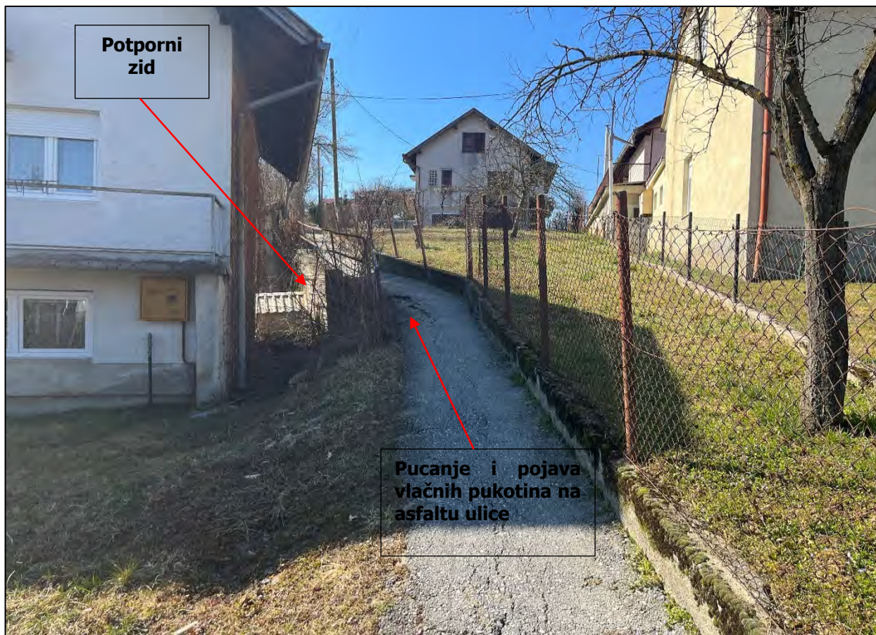
Slika 3. Prikaz klizišta u Gunduličevoj ulici i pozicije potpornog zida (pogled prema jugozapadu)
